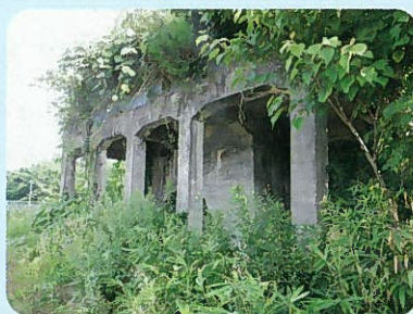
(斜坑巻き上げ機台座跡)
